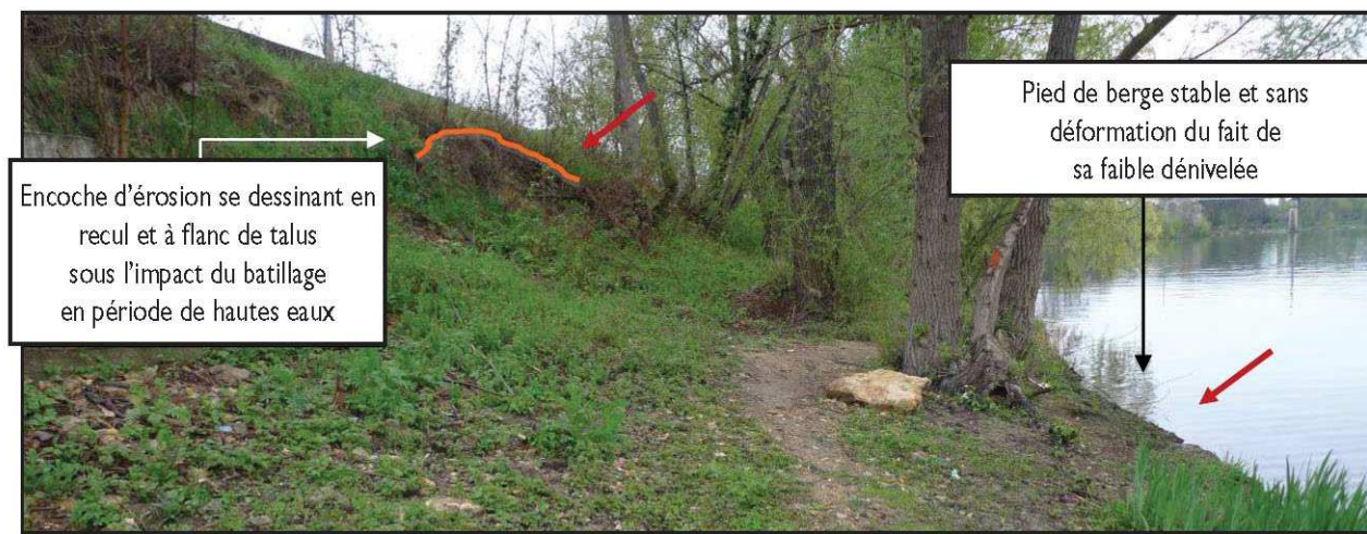
Photo 6 - Illustration du léger phénomène d'érosion en recul de la ligne de pied de rive sur le tronçon aval (Source : BIOTEC)
