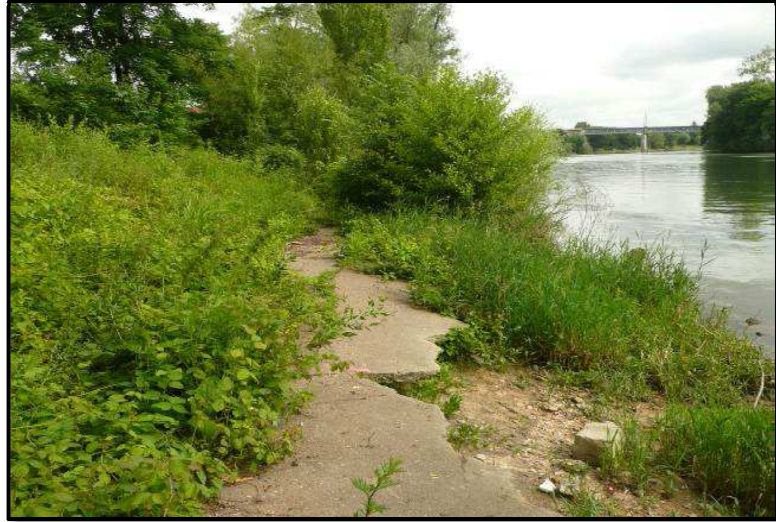
Photo 5 – Présence de vestige d'ouvrages de génie civil (Source : BIOTEC)
