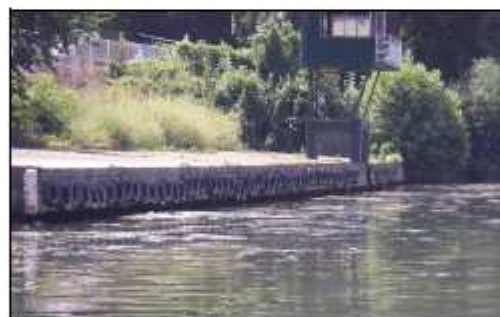
Photo 89 : Mur béton (ambiance n°C4)
