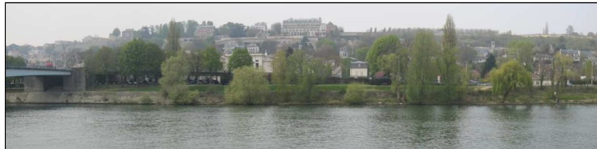
Photos 3 – Illustrations des profils de la berge gauche en aval du pont Georges Pompidou
