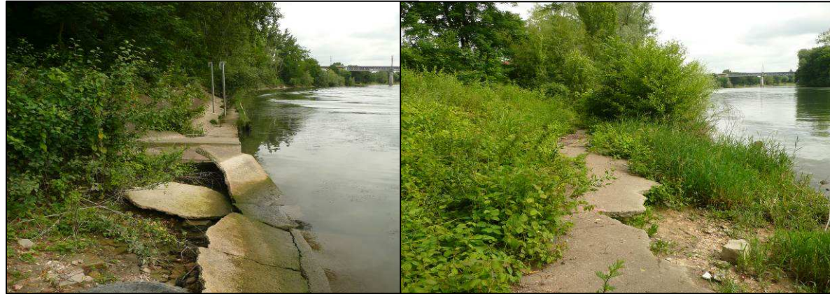
Photo 2 – Présence de vestige d'ouvrages de génie civil (Source : BIOTEC)
